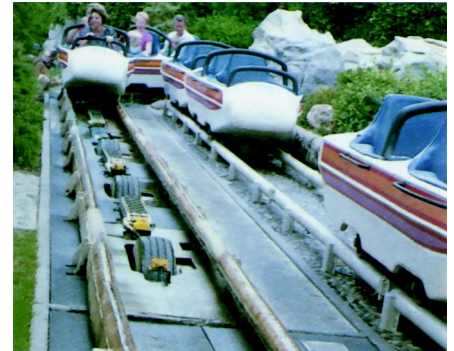
Оборудование аттракциона: контроль прихода тележки на позицию
