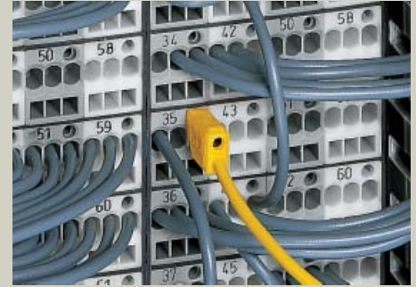
Измерение штангером 2.3 мм диаметром № заказа 210-137
