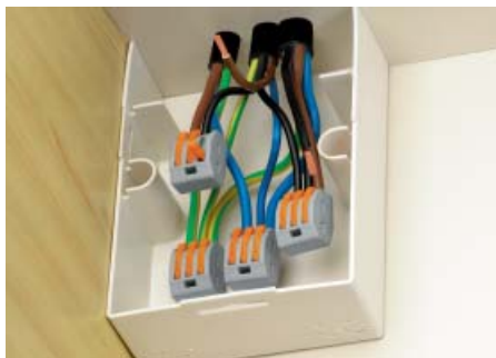
Подключение предварительно смонтированных компонентов.
