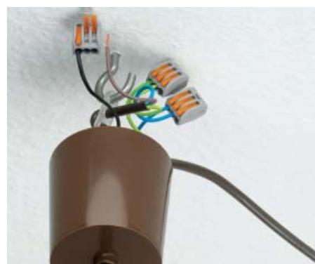
Петлевое подключение осветительного прибора гибкими проводниками.
