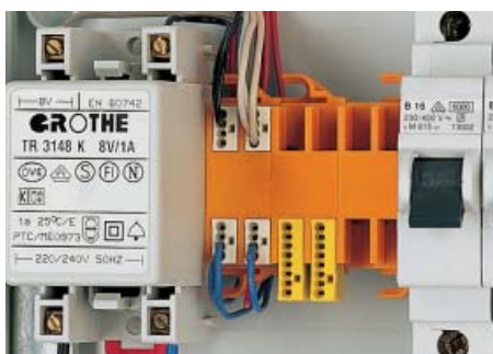
Пример монтажа охранной сигнализации в доме – монтаж на DIN-рельс 35 мм
