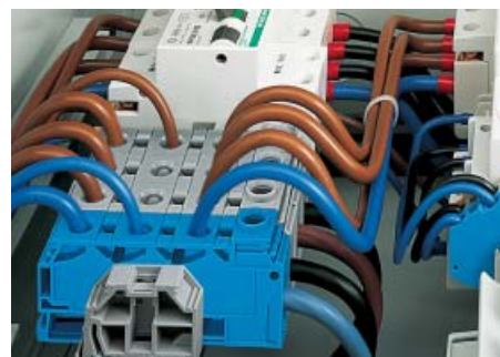
Проводники сечением до 10 мм 2 подключаются зажимом CAGE CLAMP, фронтальное подключение
