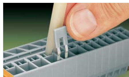
Установка перемычки типа «гребень»
