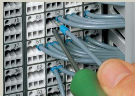
Подсоединение проводов с наконечниками
