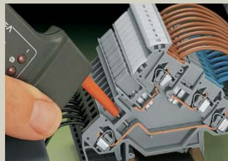
Прямое измерение напряжения на токоведущей шине
