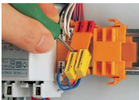
Демонтаж клеммы с кронштейна
