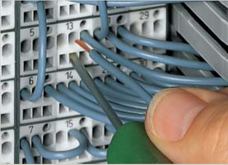
Подсоединение проводов при помощи отвертки с лезвием 2.5 x 0.4 мм, № заказа 210-119
