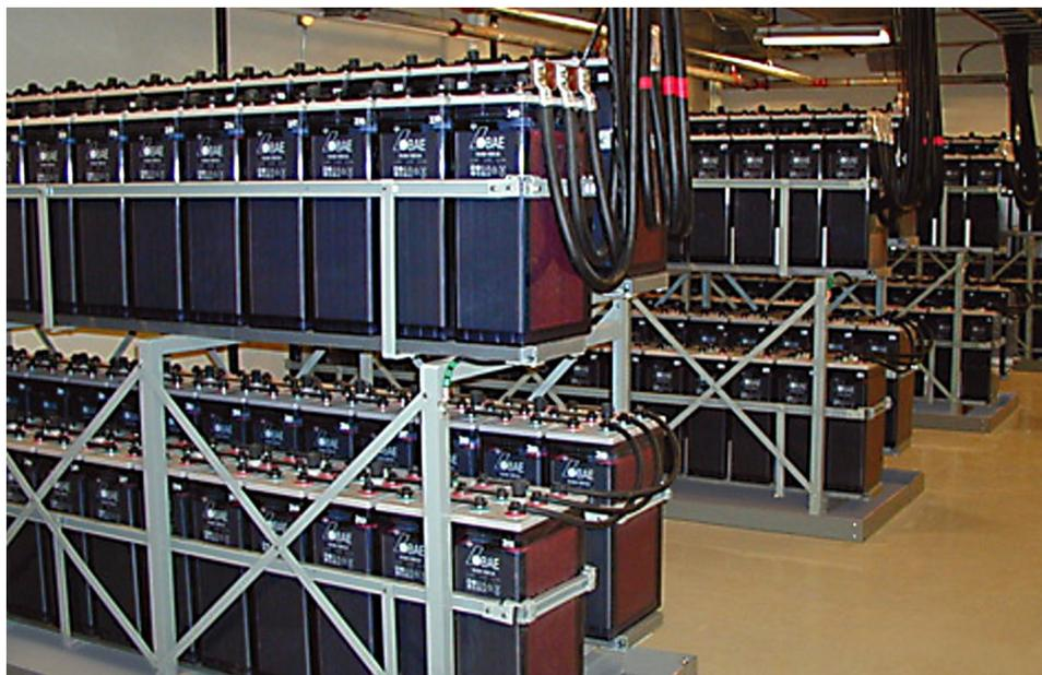
Обычно батареи OPzS поставляются сухозаряженными: батареи должны быть залиты электролитом и дополнительно подзаряжены перед использованием. Пластины уже сформированы и по специальной методике защищены против окисления. Они могут храниться без снижения свойств до 2-х лет.
