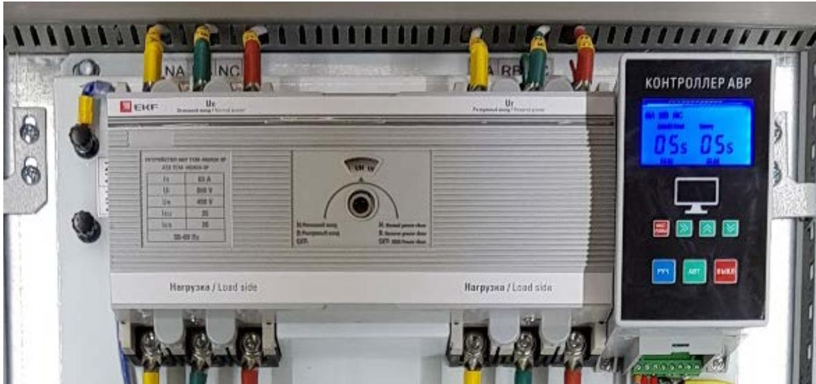
**Функции:****■ Резервирование электроснабжения нагрузки**
