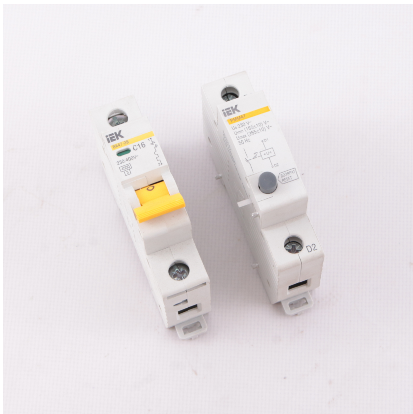
Рисунок 85 Внешний расцепитель максимального напряжения к автоматическому выключателю
